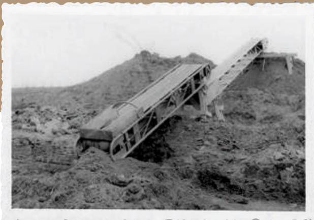
Den Tiefbau für die ersten Wohnhäuser erbrachten die Genossenschaftler mit Schaufel, Spaten und Pickle. Mit einfachen Förderbändern transportierten sie die Erde aus der Baugrube.
