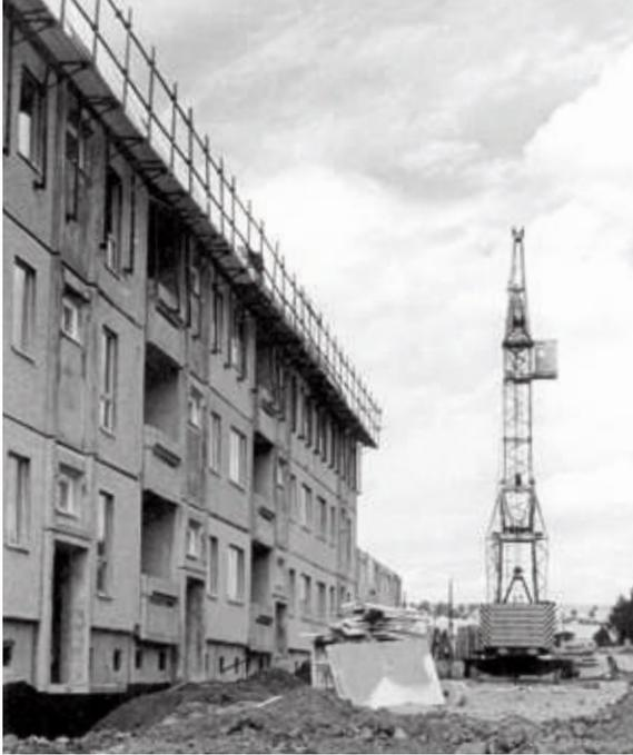
Durch die Plattenbauweise konnte der Rohbau 1988 in relativ kurzer Zeit fertiggestellt werden.
