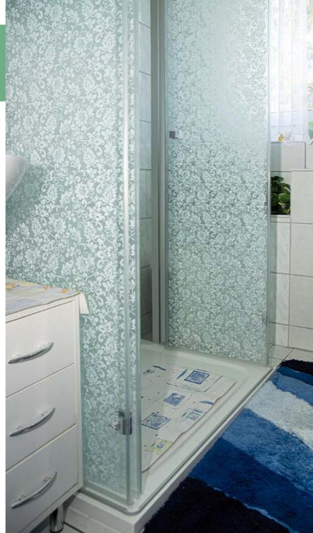
Nach dem Umbau kann die Dusche ohne Schwellen genutzt werden. Die Seitenwände der Duschkabine sind mit Scharnieren versehen und können bis zur Wand umgeklappt werden.
