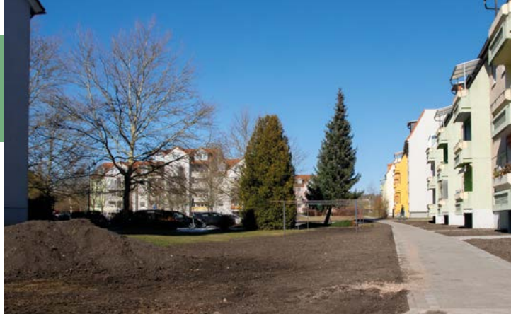
Im Februar wurde die Baumaßnahme schon vorbereitet, beispielsweise wurden die entsprechenden Bäume gefällt.
