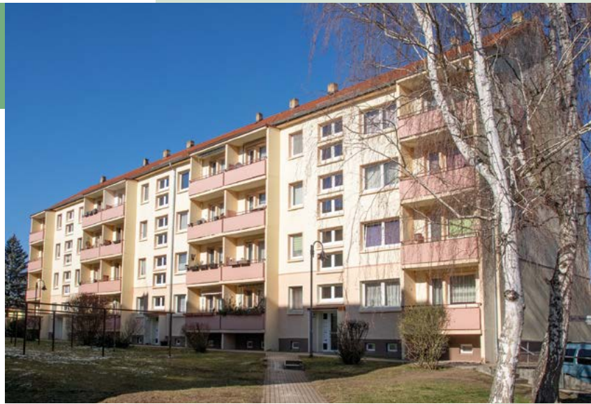
In den drei Hausaufgängen Straße des Friedens 16–18 erfolgt seit Januar die komplexe Strangsanierung der Elektroinstallation.
